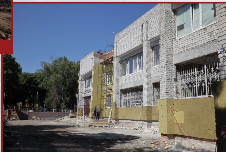
Восстановление Дворца культуры железнодорожников, повреждённого в ходе боёв за город. ДНР, Волноваха, август 2022 г.
