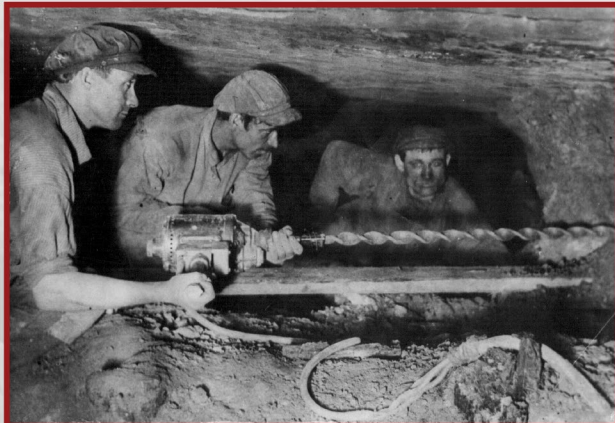
Механизация Донбасса. Электросверлильная машина за работой на Рутченковском руднике. Донбасс, 1929 г.
